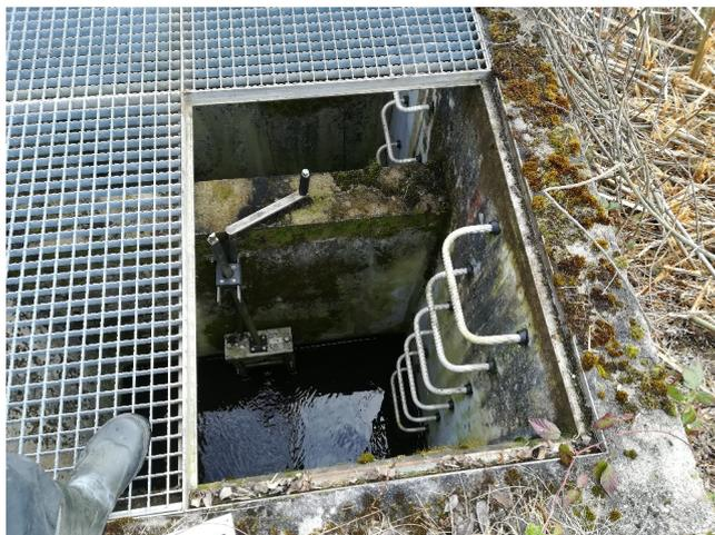
Légende : en haut de la photo, le muret central et la sortie avec vanne
