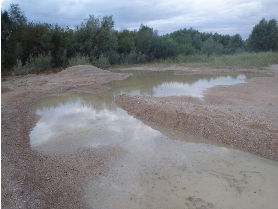
Décapage sur une grande zone, hauteur d'eau d'environ 20 cm
