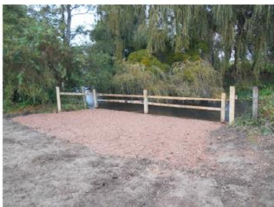
Vue de derrière d'un abreuvoir aménagé
