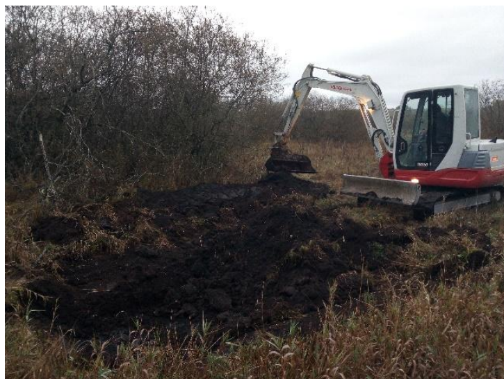
Creusement en cours – 2020
