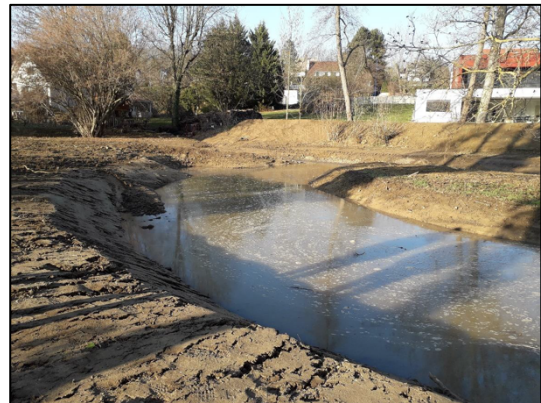
Après la première phase de travaux, 22/01/2021
