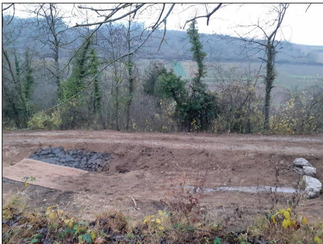
Figure 2 : Photo des travaux en cours, toile coco uniquement en fond de mare
