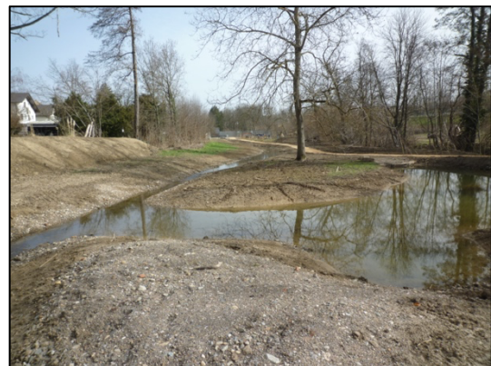
Après la première phase de travaux, 22/01/2021
