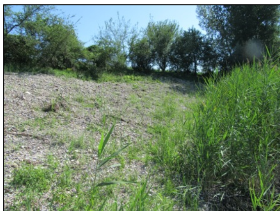
Pente adoucie de la berge nord-est, où du gravier a été régalié jusqu'au contact de la haie au sommet du talus (gauche, 08/07/2022) ; fortement revégétalisée au mois d'août, y compris par quelques roseaux (droite, 25/08/2022)
