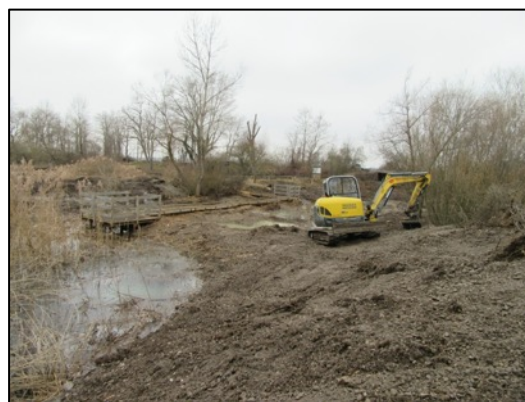
Pendant les travaux, 27/01/2022
