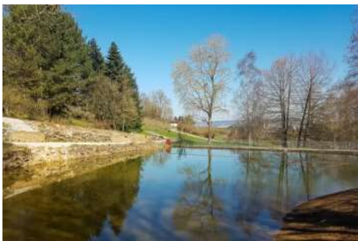
Etat de l'étang au 6 avril 2018 : mise en eau après avoir créé trois "étagements" de profondeur
